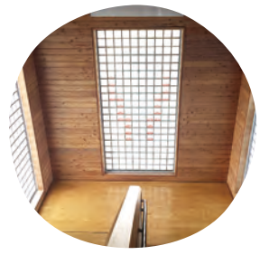
佐久穂町産のカラマツ材が、校舎のいたるところに施されています。
